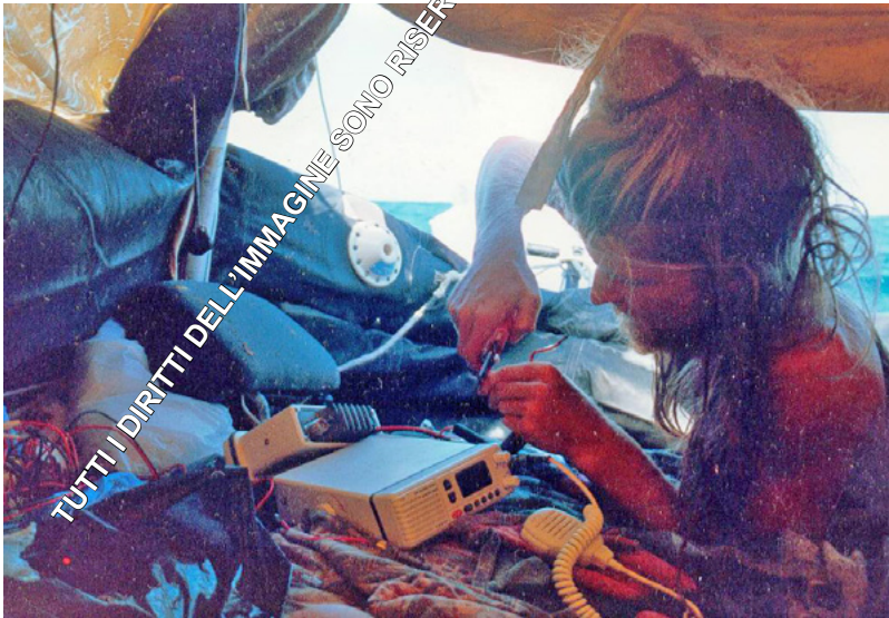
Mentre cerco di ricollegare la radio e il telefono al nuovo impianto elettrico di emergenza
